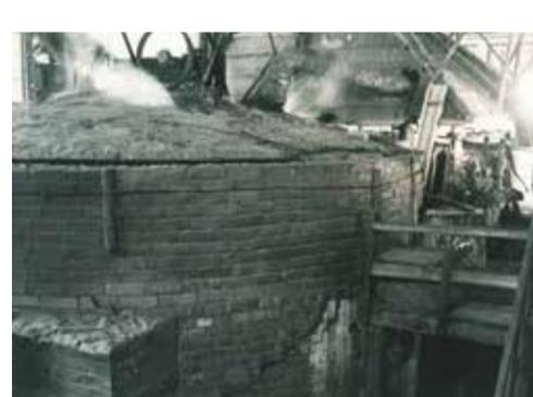
蒸気利用式塩釜の結晶釜
